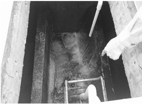
圖 12 西嶼場濾水溢流堰照片
