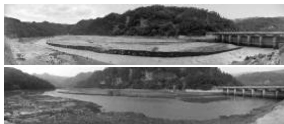
圖 4 水庫蓄水範圍水力排砂作業
