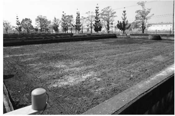
圖 6 淨水場濾池刮砂
