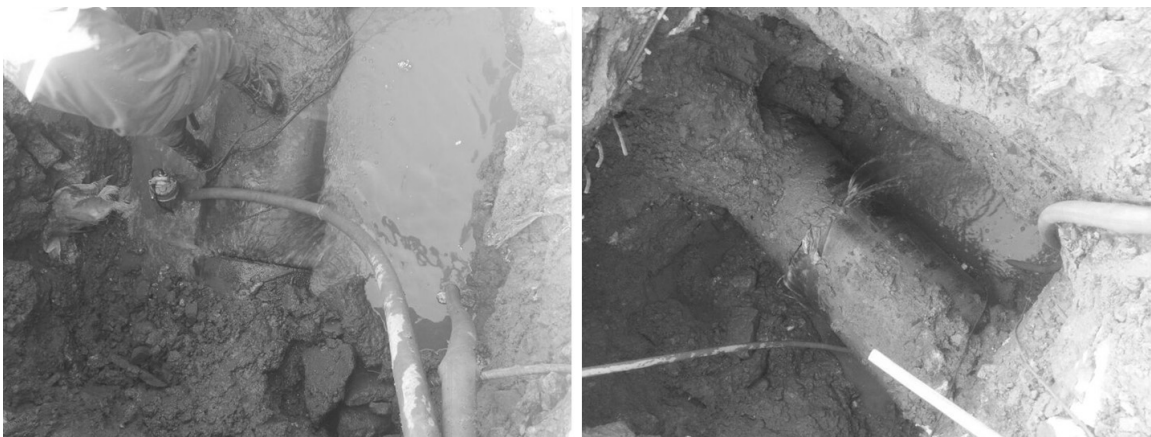
圖 44 上海浦東威立雅暗漏修復照片
