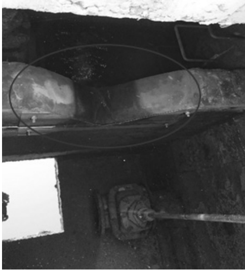
圖 5 清水溢流堰高度不足
