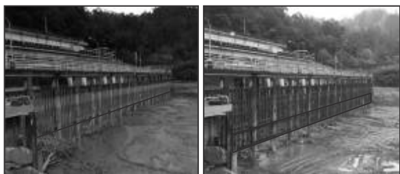
圖 2 隔欄柵施工前、後
