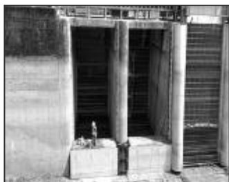
圖 3 直潭壩取水口第二道攔污柵第 8、9 門
