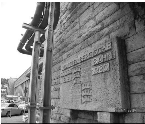
圖 2 施工中回收水管架設圖
