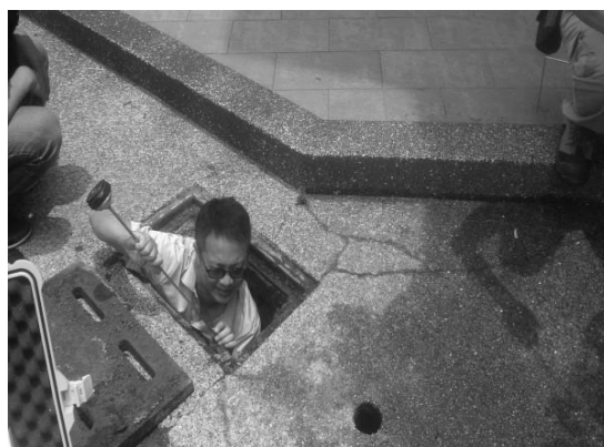
圖 5 聽音檢測竊水管線由水溝內穿越
