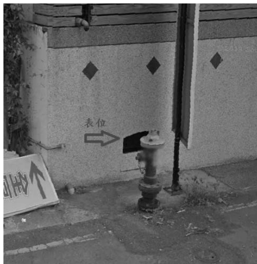
圖 1 現場表位及藥水管
