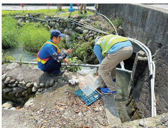
圖 24 私業者於山上引水經沿途水溝佈設明管而下，檢漏員沿管逐段檢驗水質
