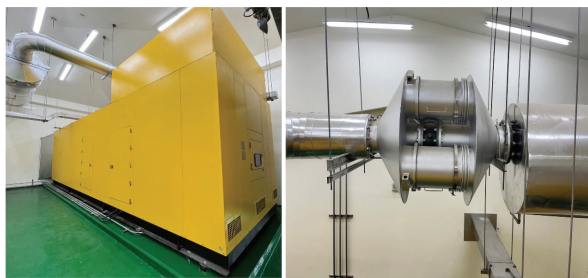
圖 8 發電機組及觸媒淨化排煙系統
