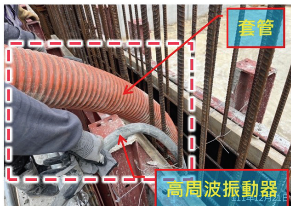
圖 12 套管伸入牆身及使用高周波振動器
