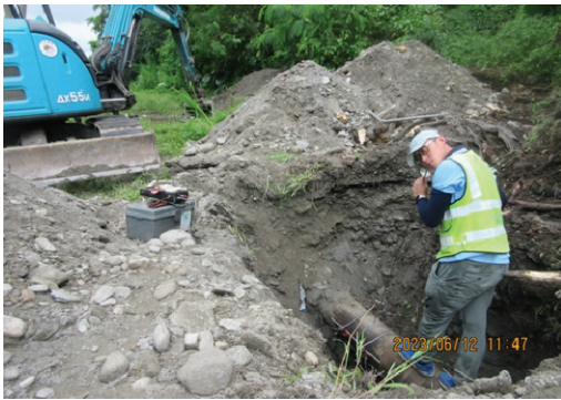
圖 9 夾管超音波二分法計量-聽音研判
