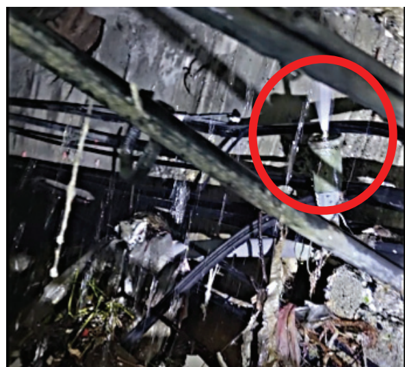
圖 22 大橋下的民用小型減壓閥漏水
