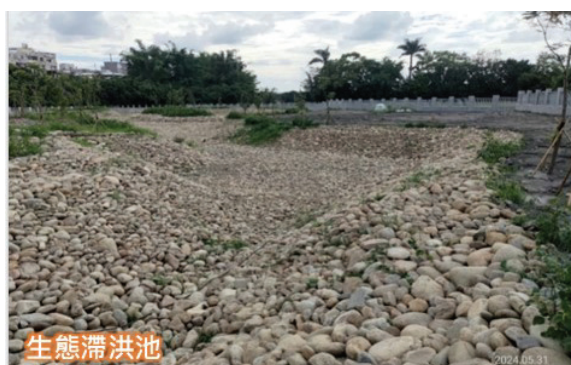
圖 4 滯洪池砌塊石邊坡
