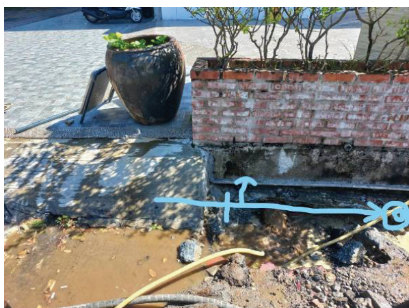
圖 21 竊水源頭，竟是既設 \phi 25 水表，因人行道重整，水表須後移 1 公尺所致
