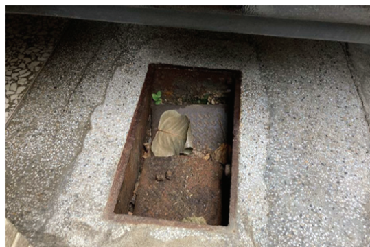
圖 1 水量計箱蓋結構破損
