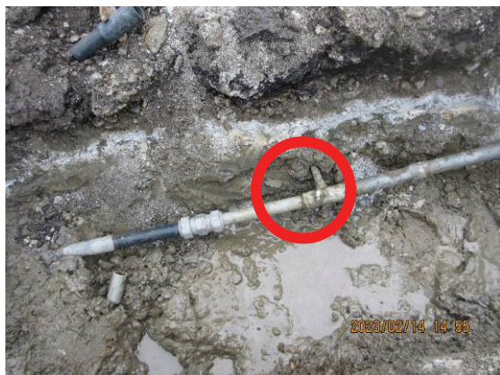
圖 15 檢出疑似 20*13mm 竊水分歧管，斷管接 \phi 20 直管後，最小率為 0\%=(0\div 21)
