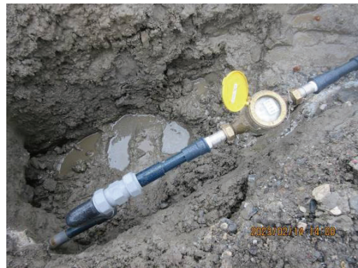
圖 13 小巷內以 \phi 20 水表計量測試
