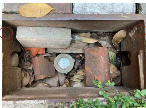
圖 2 水量計箱上蓋支撐結構斷裂
