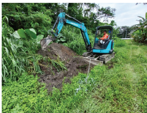
圖 8 夾管超音波二分法計量-開挖
