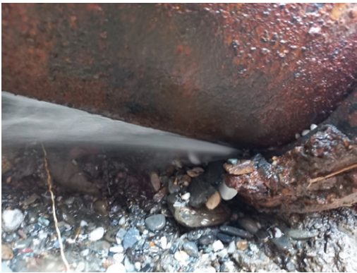
圖 10 「超音波二分法計量」終覓出漏水點，係 \phi 300 DIP 套管接頭，疑似碎石入膠圈內，歸屬為「施工不良」所致
