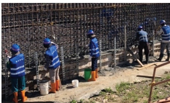
圖 13 專人搗實止水帶二側混凝土
