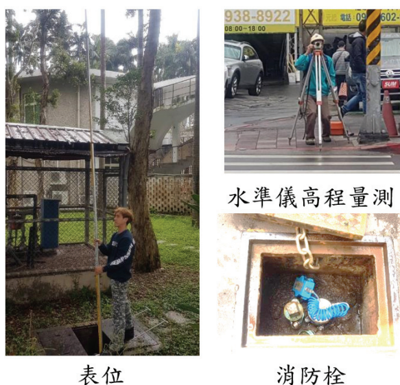
圖 5 表位、消防栓水準儀高程量測
