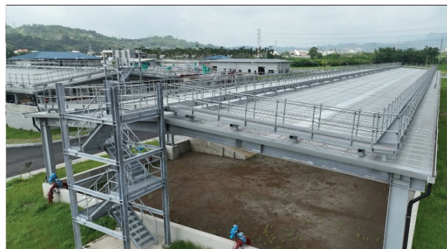
圖 7 鋼構屋頂設置走道及扶手欄杆
