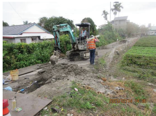
圖 14 分段開挖以管帽封管計量測試
