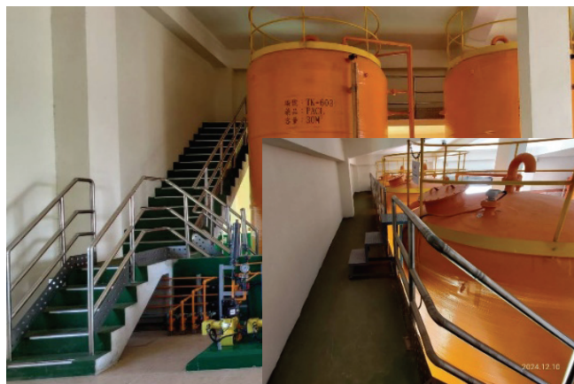
圖 6 加藥房設置 RC 樓梯及操作平台
