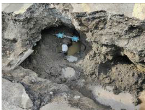
圖 11 封除舊有三通管
