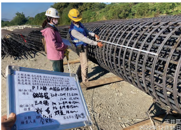
圖 11 全套管基樁鋼筋籠組立抽查
