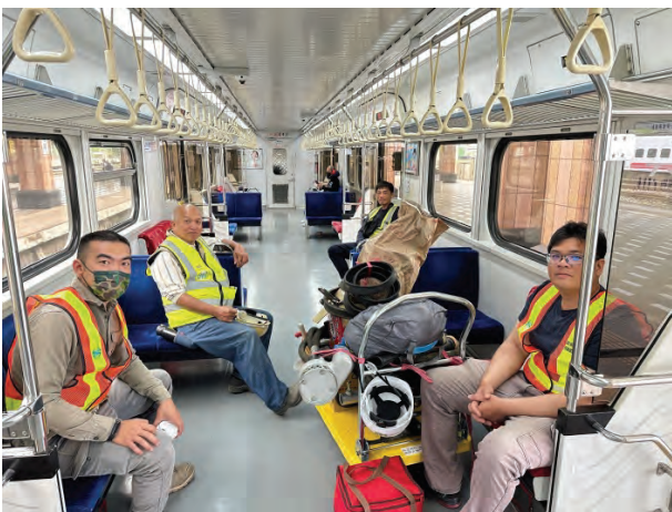
圖 17 和平系統大漏水，4月5日修漏工作由九區玉里營運所巫主任怡穎，率領該所曾參加台水 50 週年/搶修達人競賽的同仁，共搭火車前往維修。
