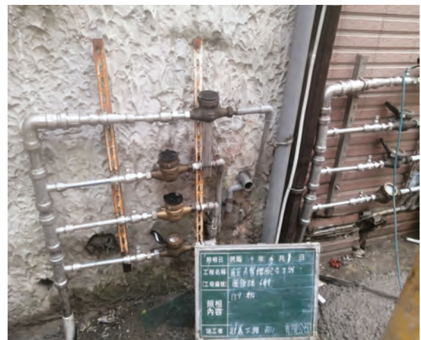
圖 6 玫瑰城社區管線施工
