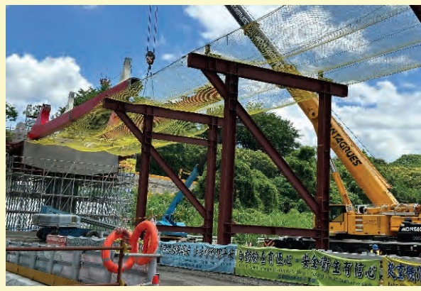
圖 17 水管橋鋼結構吊裝
