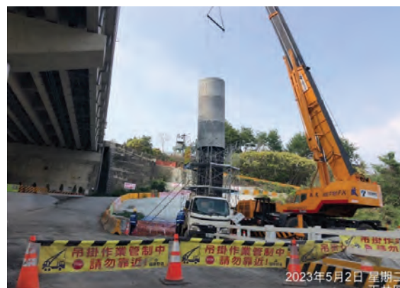
圖 14 橋墩防撞鋼版吊裝
