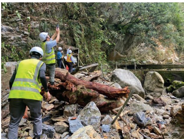
圖 12 富世取水口，便道及電動閘遭落石砸毀
