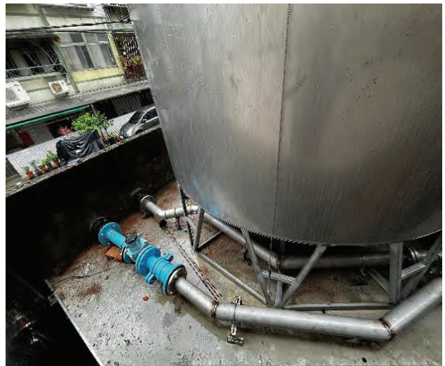
圖 14 仙岩山莊配水管汰換
