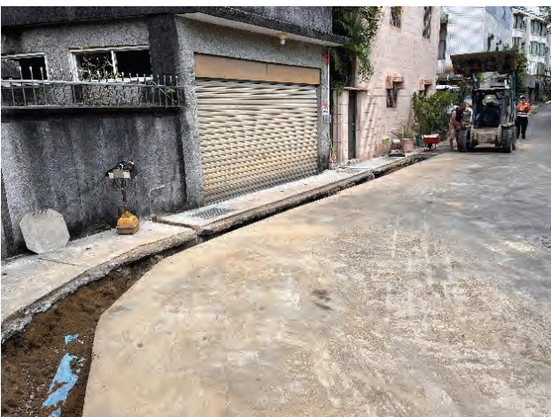
圖 12 仙岩山莊配水管線汰換
