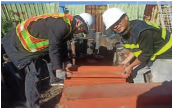
圖 2 槽鋼護板施工需 2 個人搬運
