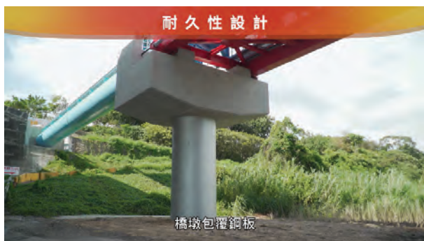
圖 8 橋墩包覆鋼板
