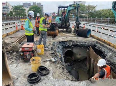
圖 10 \phi 600DI 過橋管脫接施工
