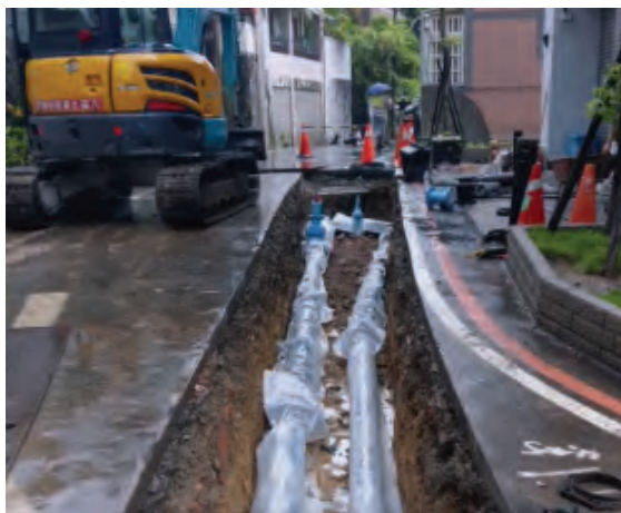
圖 3 玫瑰城社區管線施工
