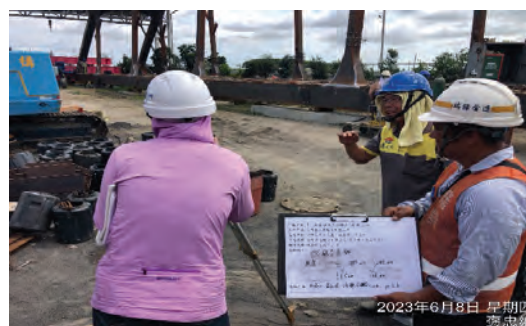
圖 16 鋼結構構件模擬安裝抽查
