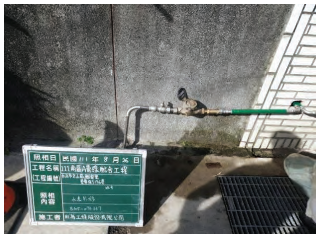
圖 15 仙岩山莊給水管線汰換
