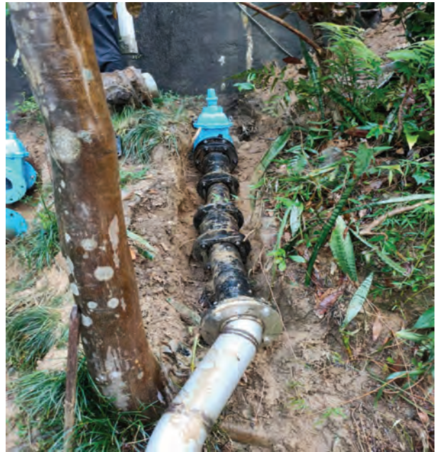
圖 4 玫瑰城社區管線施工
