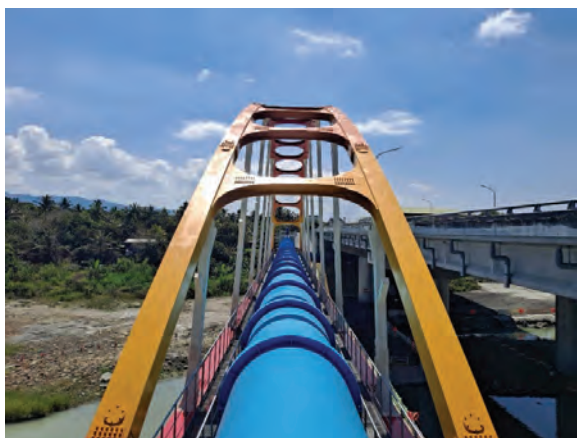
圖 18 鋼拱橋完成情形
