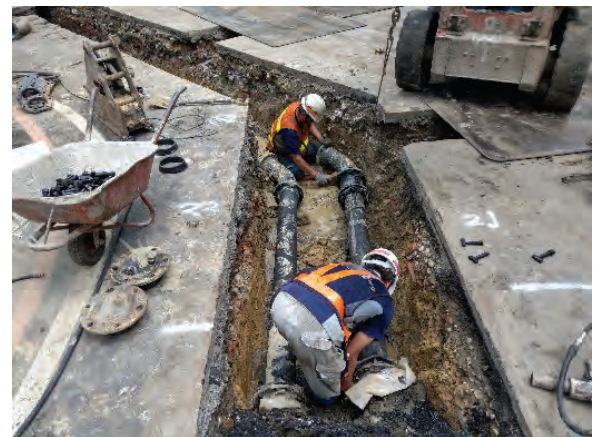
圖 5 玫瑰城社區管線施工
