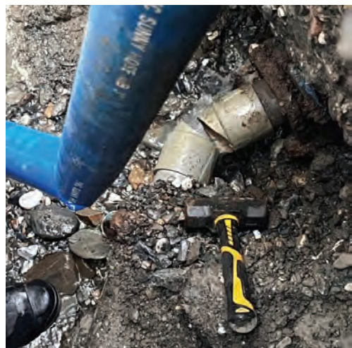
圖 18 僱請當地挖土機開挖，由九區玉里所員工，自行修復和平 \phi 80 PVC 肘管大漏水
