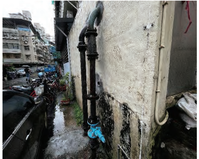
圖 13 仙岩山莊配水管線汰換
