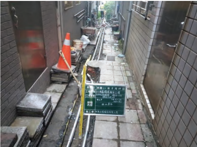
圖 11 仙岩山莊管給水管線汰換
