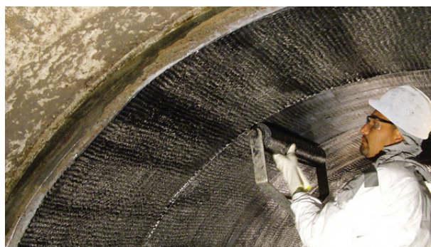
圖 1 纖維加固管道維修
