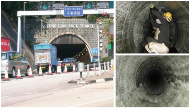
圖 5 獅子山隧道水管修復
