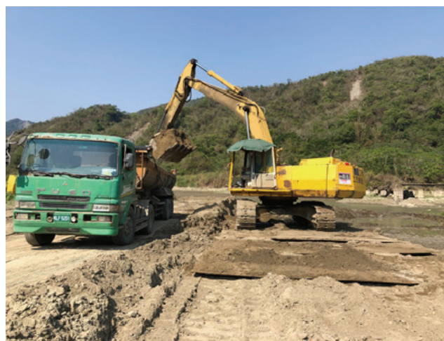
圖 2 南化水庫 2020 年枯旱清淤施工照片
