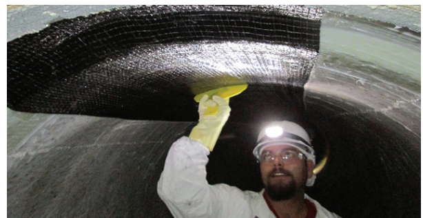
圖 2 WSSC 66 英吋纖維加固管道維修
