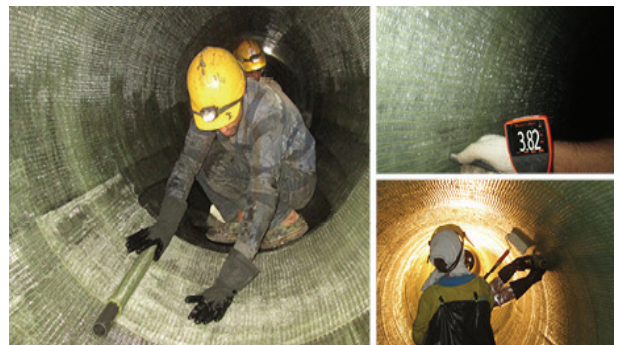
圖 4 東江水管修復
