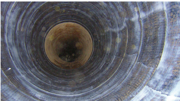
圖 3 霍華德縣鐵道下 36 英吋纖維加固管道維修
