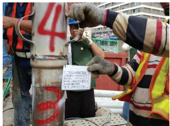
圖 4 下管作業確認濾管位置及標示
