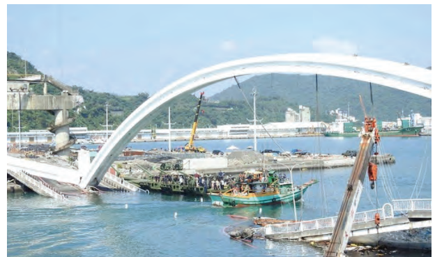
圖 1 宜蘭縣南方澳大橋意外斷裂坍塌
