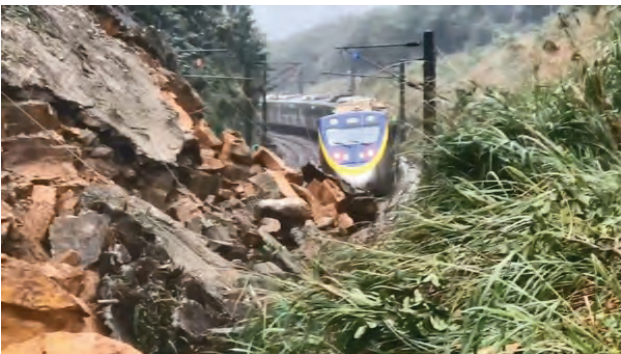
圖 3 台鐵瑞芳至猴硐連續豪雨造成邊坡下滑
