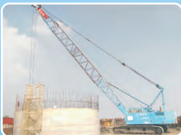
輻射井-沉箱工程
