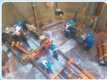
輻射井-推管工程
