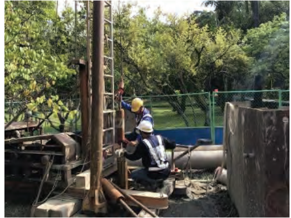
圖 6 水井施工直度測試作業
