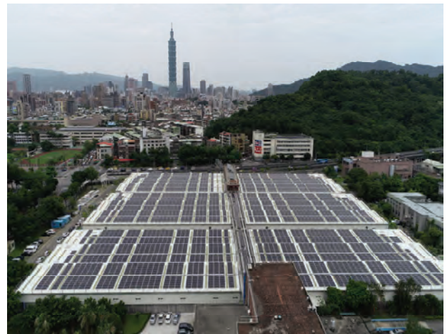
圖 7 長興淨水場鋪設太陽能板情形
