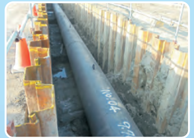
輸水管路工程
