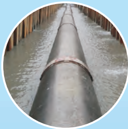
集水暗管埋設工程
