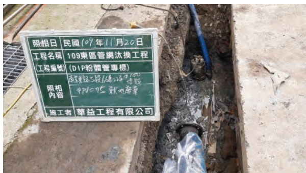
圖 10 PVC 舊管打碎後就地廢棄
