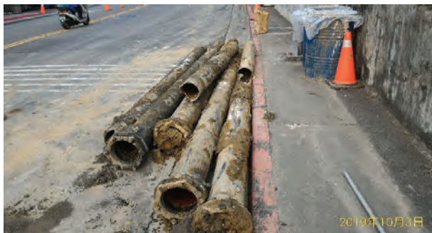
圖 7 管線汰換工程舊管拆除繳庫
