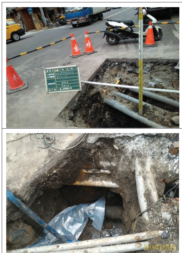
圖 2 管溝開挖現場管障狀況
