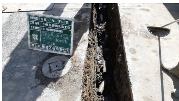
圖 9 就地廢棄管線確實封管
