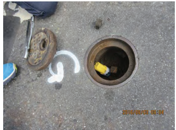
圖 8 掀開蓋佈放感測器磁吸管件
