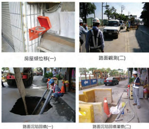
圖 15 路面監測及回填圖
