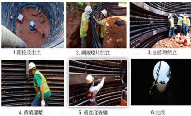
圖 6 鋼襯板施工圖
