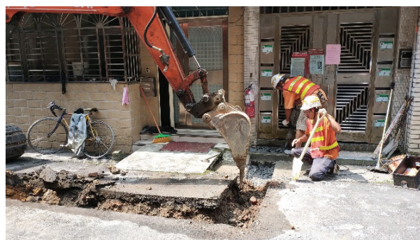
圖 4 現場施工改善
