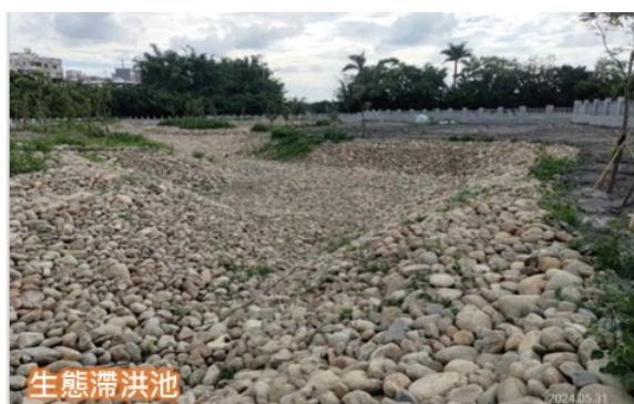
圖 4 滯洪池砌塊石邊坡
