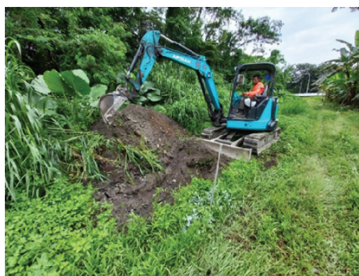
圖 8 夾管超音波二分法計量-開挖
