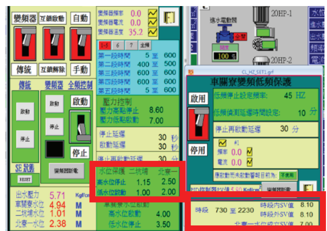
圖 3 車關寮加壓站監控畫面
