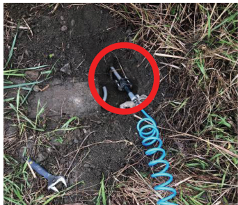
圖 5 斷管後以伸縮接頭連接漏水疑慮管
