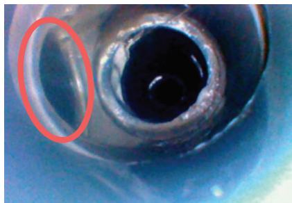
圖 10 檢測竊水管訓練課程-實作檢視出竊水分歧管
