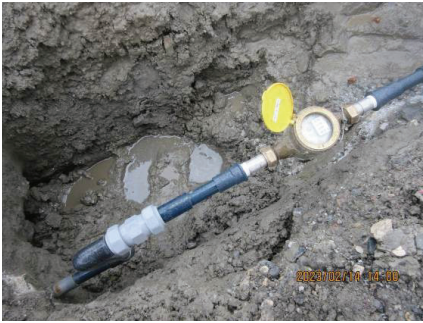
圖 1 小巷內以 \phi 20 水表計量測試
