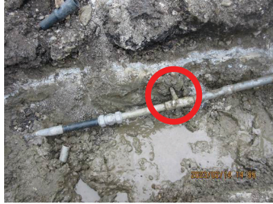
圖 3 檢出疑似 20 \times 13\text{mm} 竊水分歧管,斷管接 \phi 20 直管後,最小率為 0\%=(0+21)
