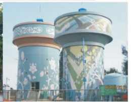
金門地區新建高架水塔、配水池及加壓站工程
