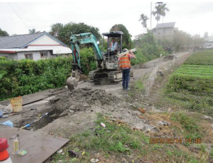
圖 2 分段開挖以管帽封管計量測試
