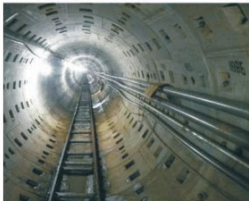
輸水幹管潛盾工程
