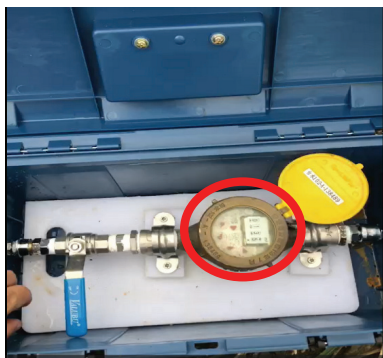
圖 7 通過小表三角指針是否轉動，以計量該不明管線之流量
