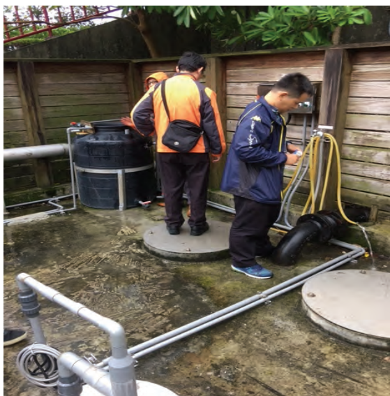
圖 6 配水池加氯設備操作測試及採樣
