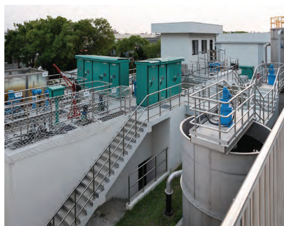
圖 6 台水自來水專業訓練園區傳統設備實習場
