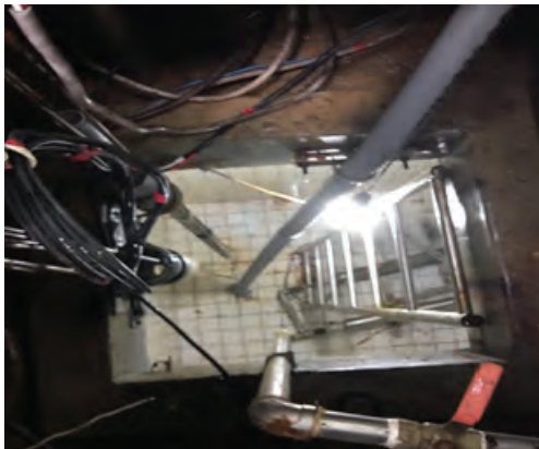
圖 3 進水管導流延伸至池底
