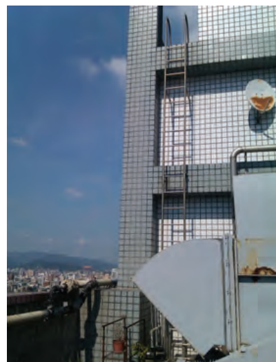
圖 5 爬梯距離外牆太近且無護籠
