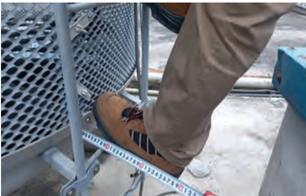
圖 6 踏條與牆面距離不足(此為冷卻水塔爬梯)
