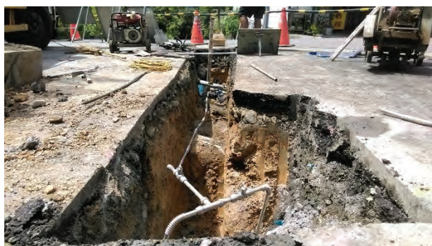
圖 8 直飲台改由揚水管接水施工現場
