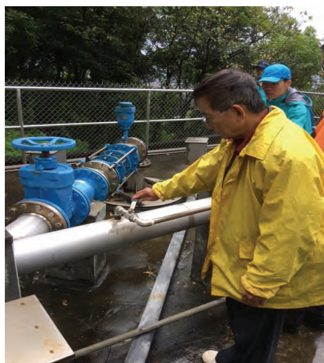
圖 9 三配洩壓閥旁通管回流閥調整開度
