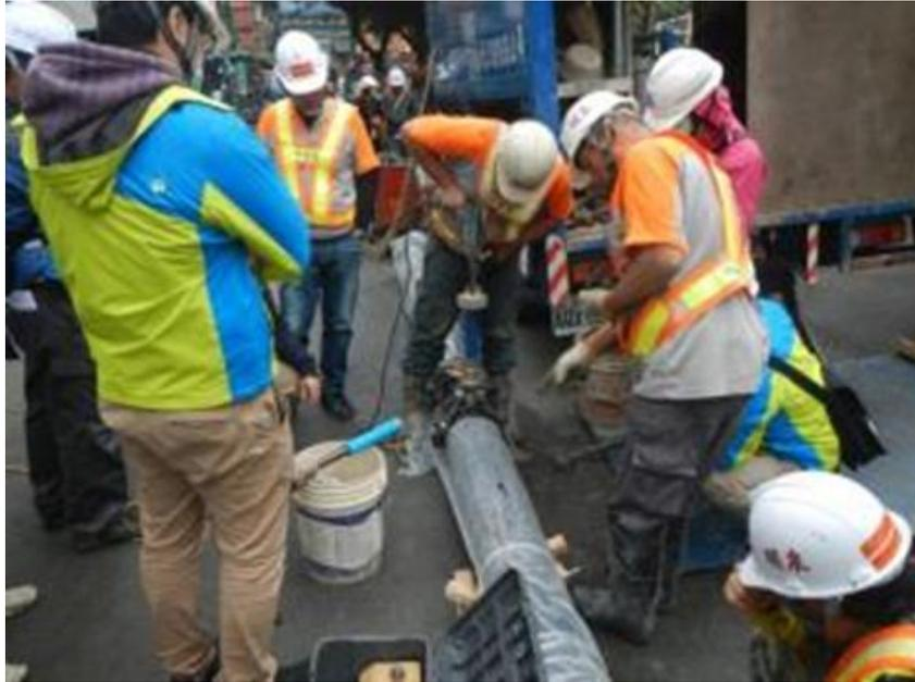
圖4-54 耐震接頭(NS型)粉體塗裝內襯所使用之電動鑽孔機
