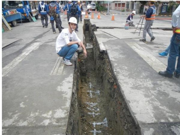
圖4-48 管溝全部清出後日本專家於管溝下規劃配管噴漆
