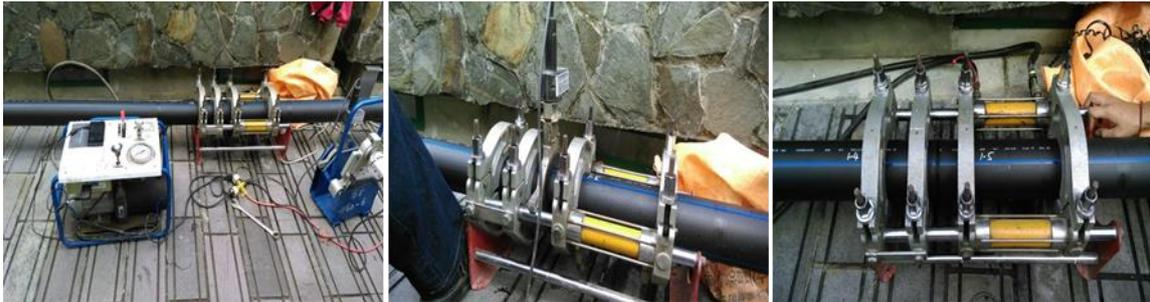
圖4-92 熱熔對接法施工示意圖
