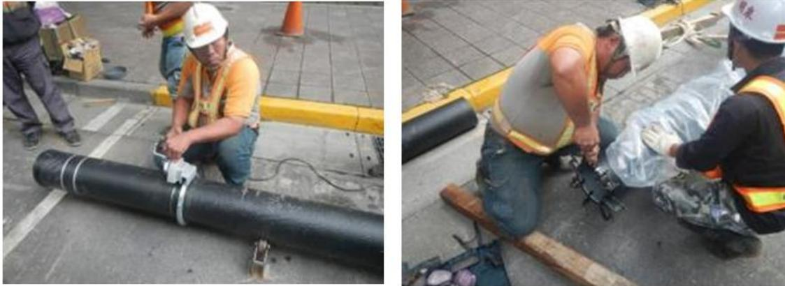
圖4-50 直管切管與插口環處理較為費時
