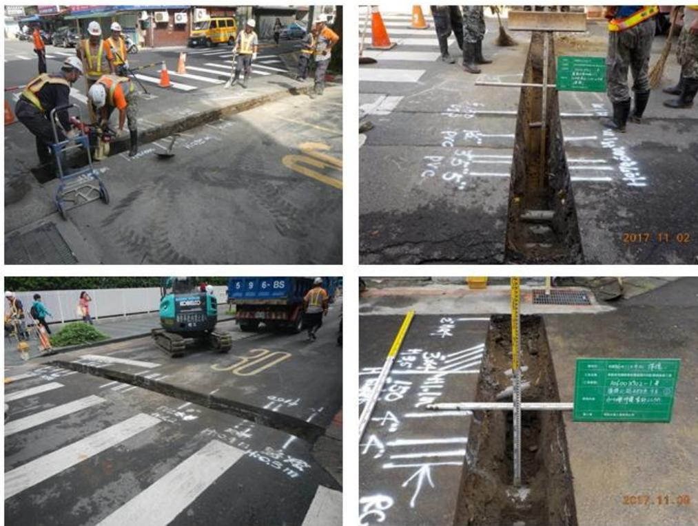
圖4-46 北水處試辦工程標施工前第1階段探挖情形
