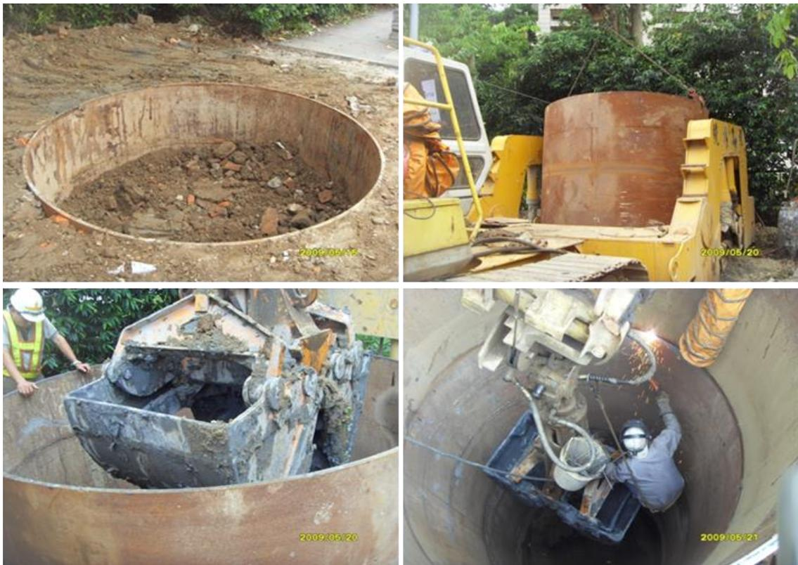
圖4-80 圓形鋼管壓入土壤並掘削運棄土壤
