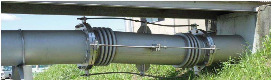
圖2-94 於東日本大地震發揮功效的不鏽鋼伸縮管<sup>74</sup>
