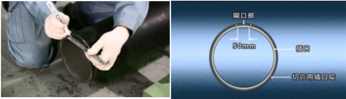
圖4-27 切管後插口端開口部標示長度50mm記號
