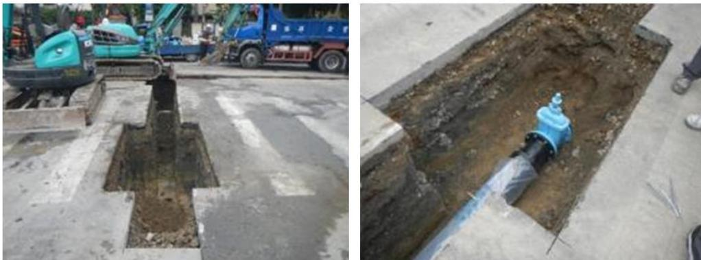
圖4-47 施工初期接頭處擴挖完成2.0公尺 x 1.4公尺
