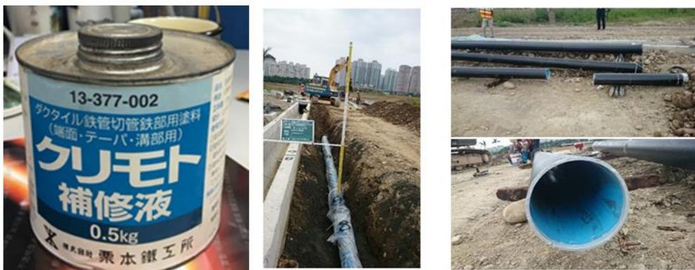
圖5-25 粉體塗裝管切管後修補夜修補情形
