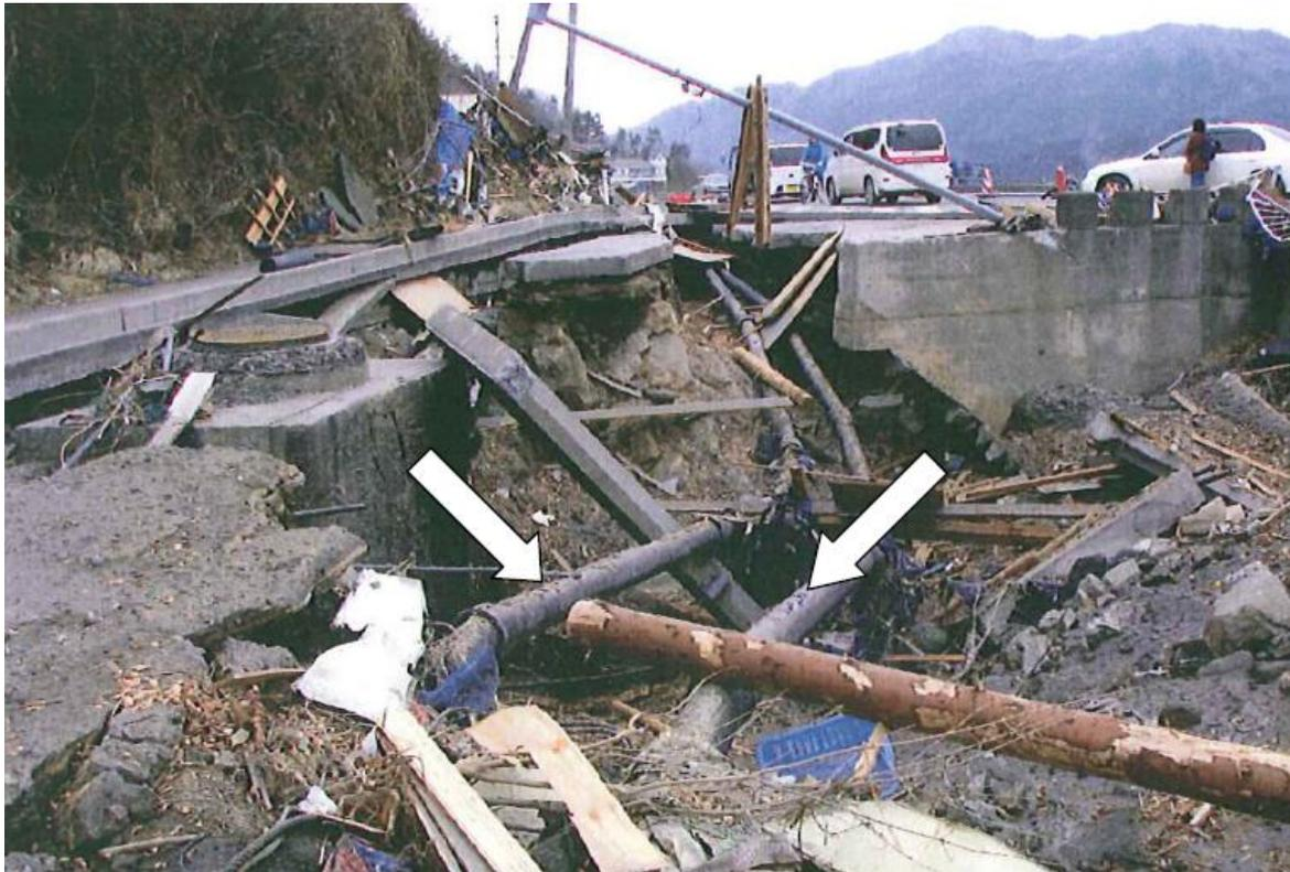
圖2-72 東日本大地震後地下管道只有耐震接頭無損(詳箭頭)<sup>68</sup>
