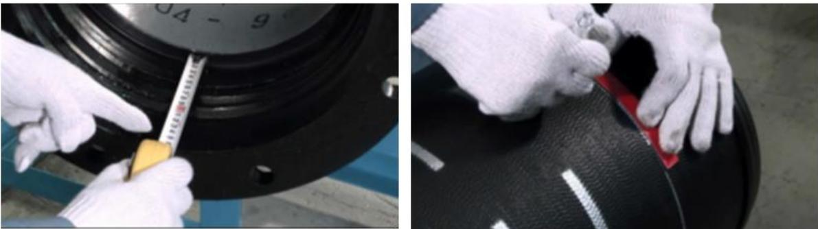
圖4-38 確認管件承口深度並在直管承口上標示
