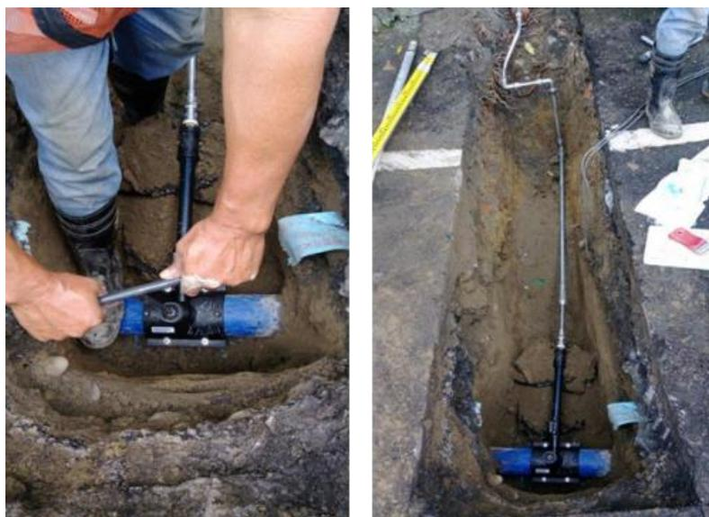
圖4-102 鞍帶分水栓鑽孔及給水管件安裝
