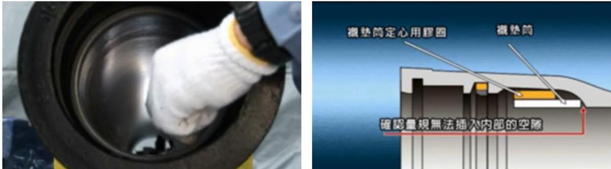
圖4-32 確認直管承口襯墊筒與承口壁之間隙
