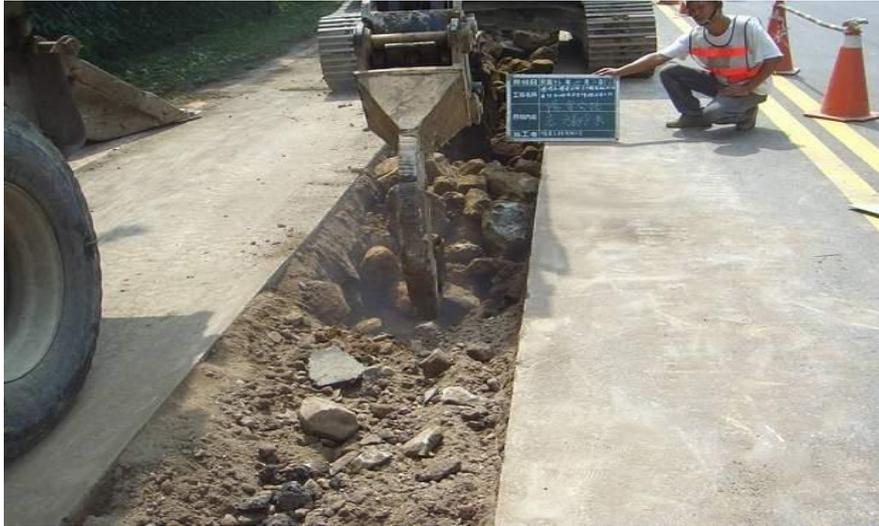
圖4-95 管溝岩方破碎打除
