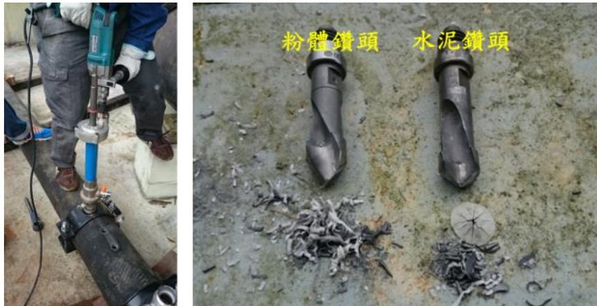
圖5-15 電動鑽孔機與粉體鑽頭
