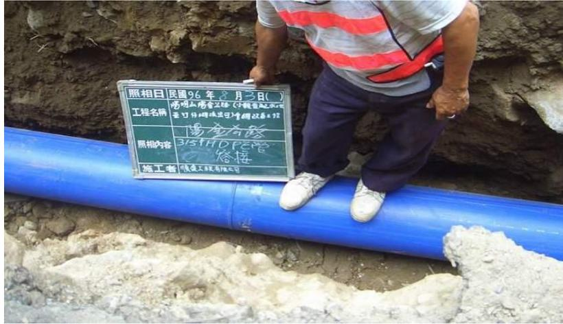
圖4-98 HDPE管熱熔對接施工完成
