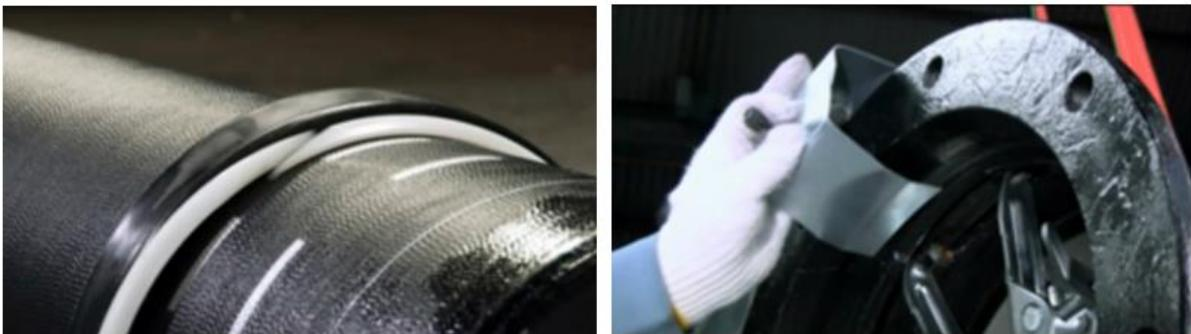
圖4-39 安放止水橡膠圈、背托環並裝上賞擋板
