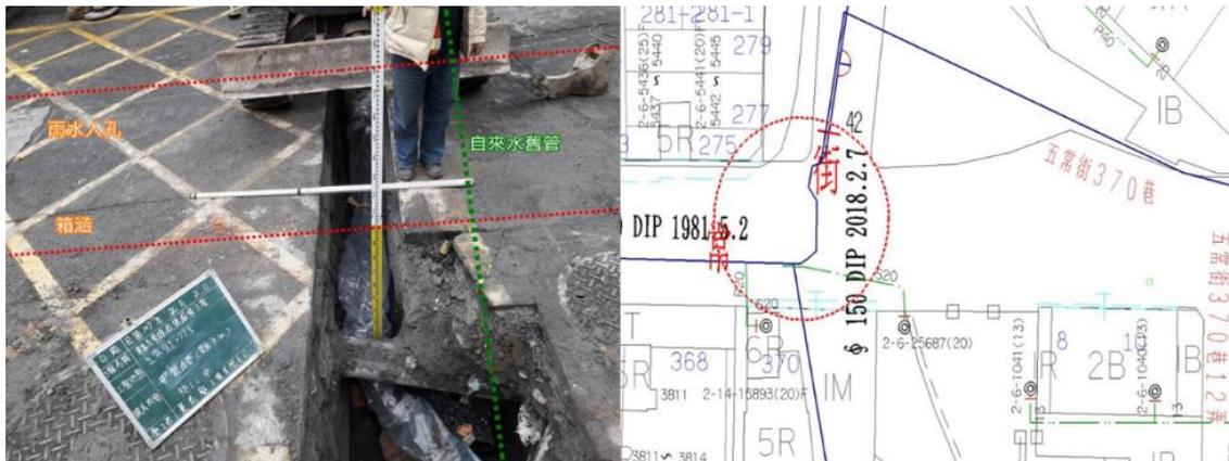
圖4-82 自來水管線以原口徑進行管線遷移改善
