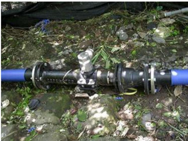
圖4-94 法蘭機械接頭接法施工示意圖
