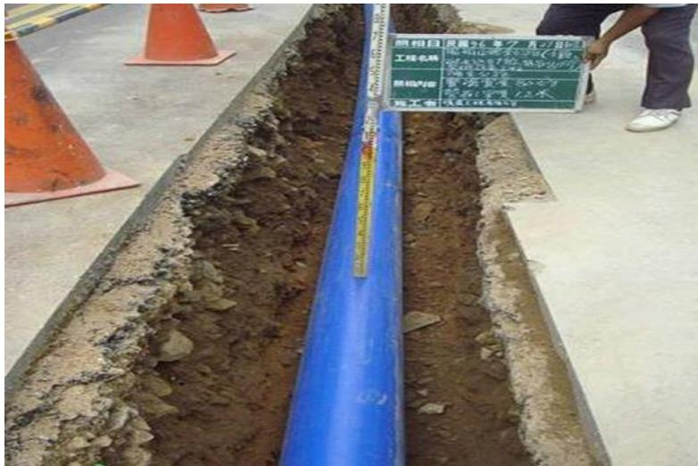
圖4-99 HDPE管安裝完成情形
