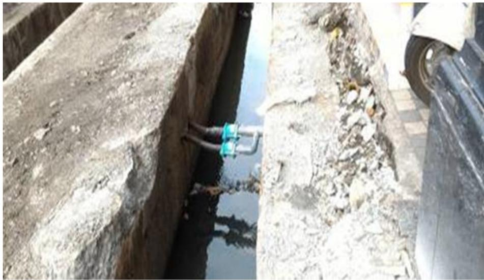
圖4-68 給水管線橫越側溝
