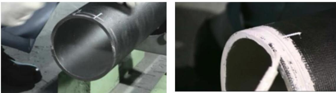
圖4-29 切管後插口端使用專用修補液進行修補
