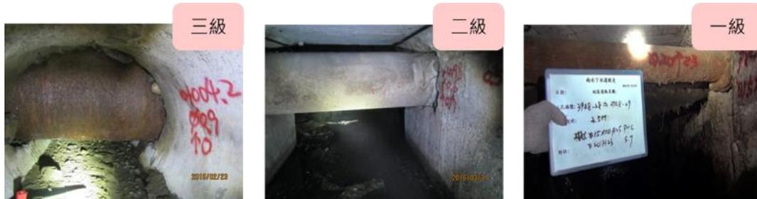
圖4-75 管線橫越雨水箱涵影響程度分級
