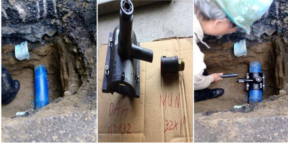
圖4-100 管溝開挖至HDPE管並安裝鞍帶分水栓
