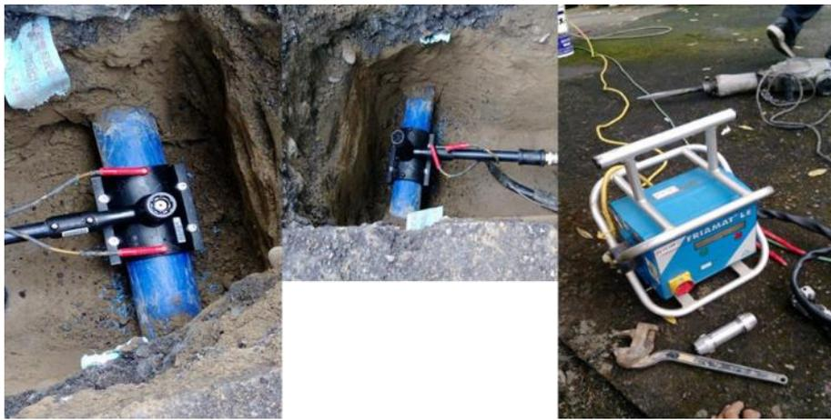
圖4-101 電熔加熱鞍帶分水栓
