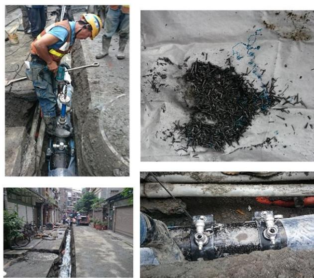
圖5-16 粉體塗裝管20mm給水鞍帶鑽孔測試
