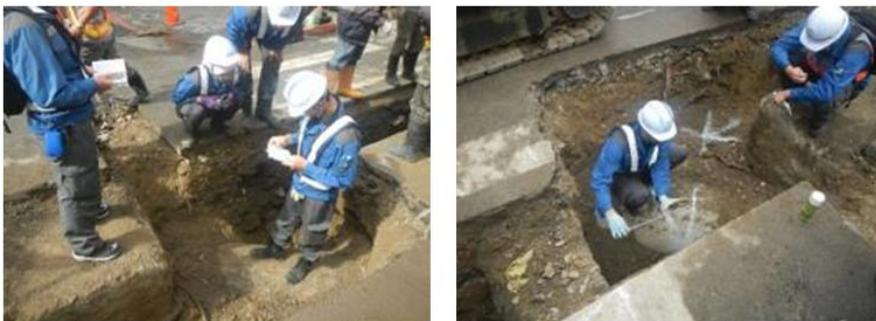
圖4-49 耐震接頭(NS型)遇管障需反覆測量規劃配管
