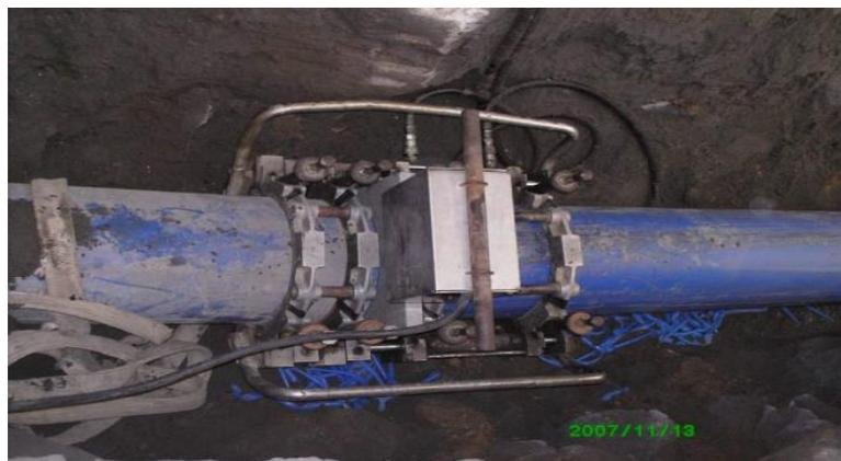
圖4-97 管溝內HDPE管熱熔對接施工
