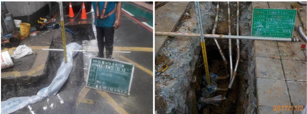
圖4-85 縮小管線口徑或以多支50mmSSP進行連接
