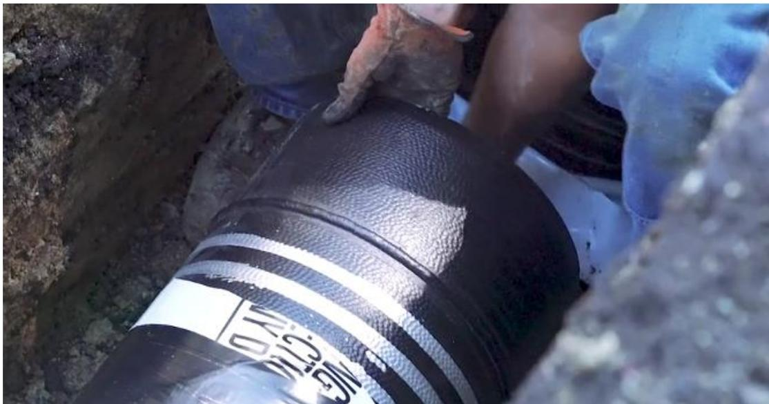
奧勒岡州埋設的耐震管，管尾銲接的擋環(U.S. Pipe網站)
