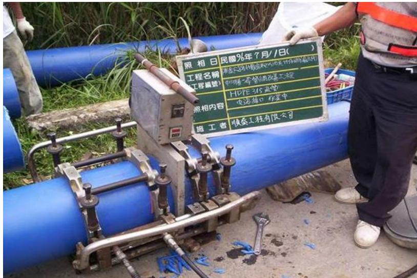
圖4-96 管溝外HDPE管熱熔對接施工
