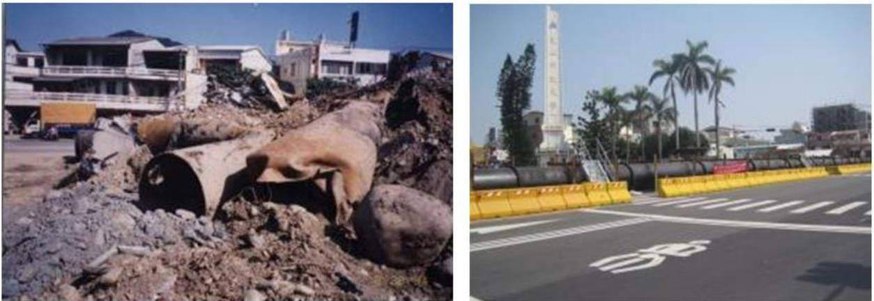
圖4-1 地震後輸水幹管受損情形及沿主要道路鋪設的明管
