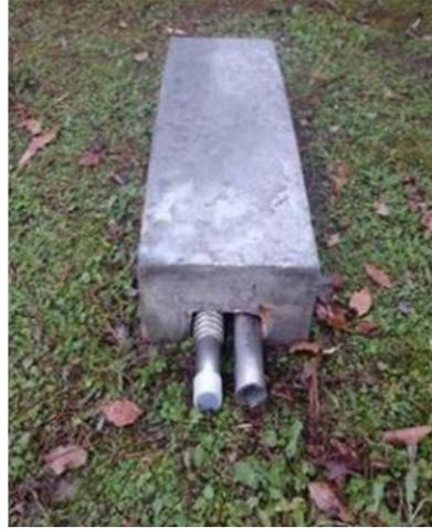
圖4-72 50mm以下給水管線由第一單元穿越
