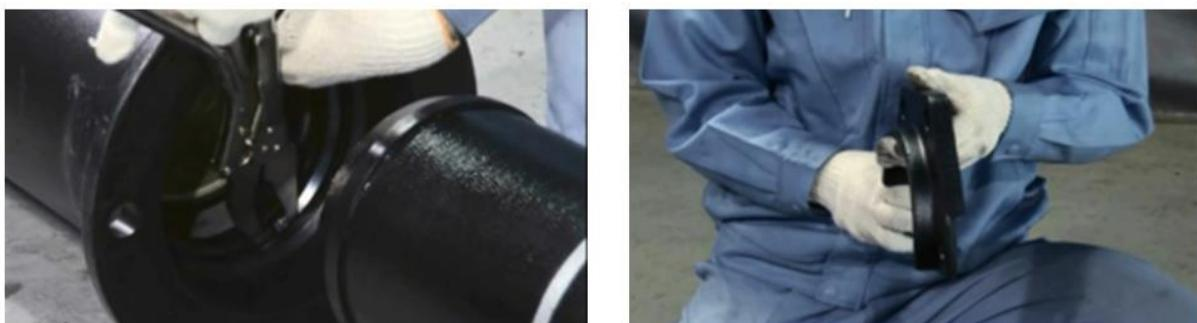
圖4-19 續接管脫環及定心用橡膠圈再度裝上
