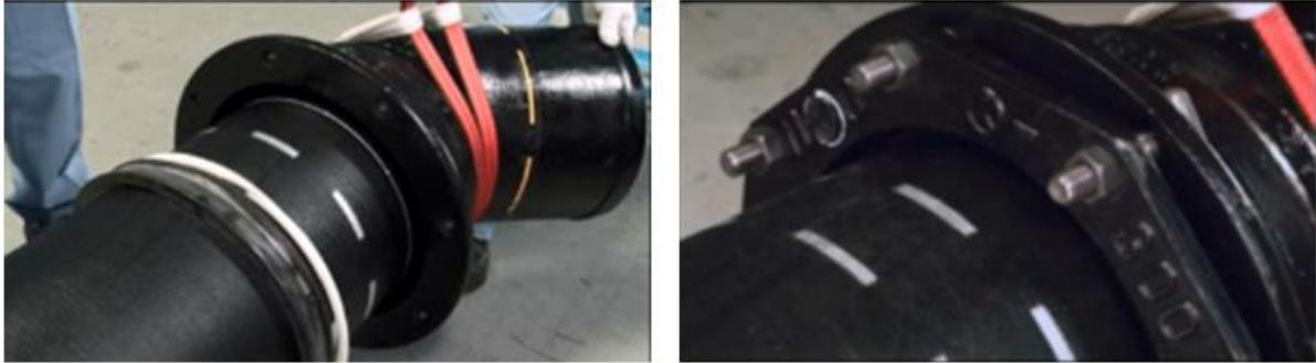
圖4-40 確認橡膠圈位置
