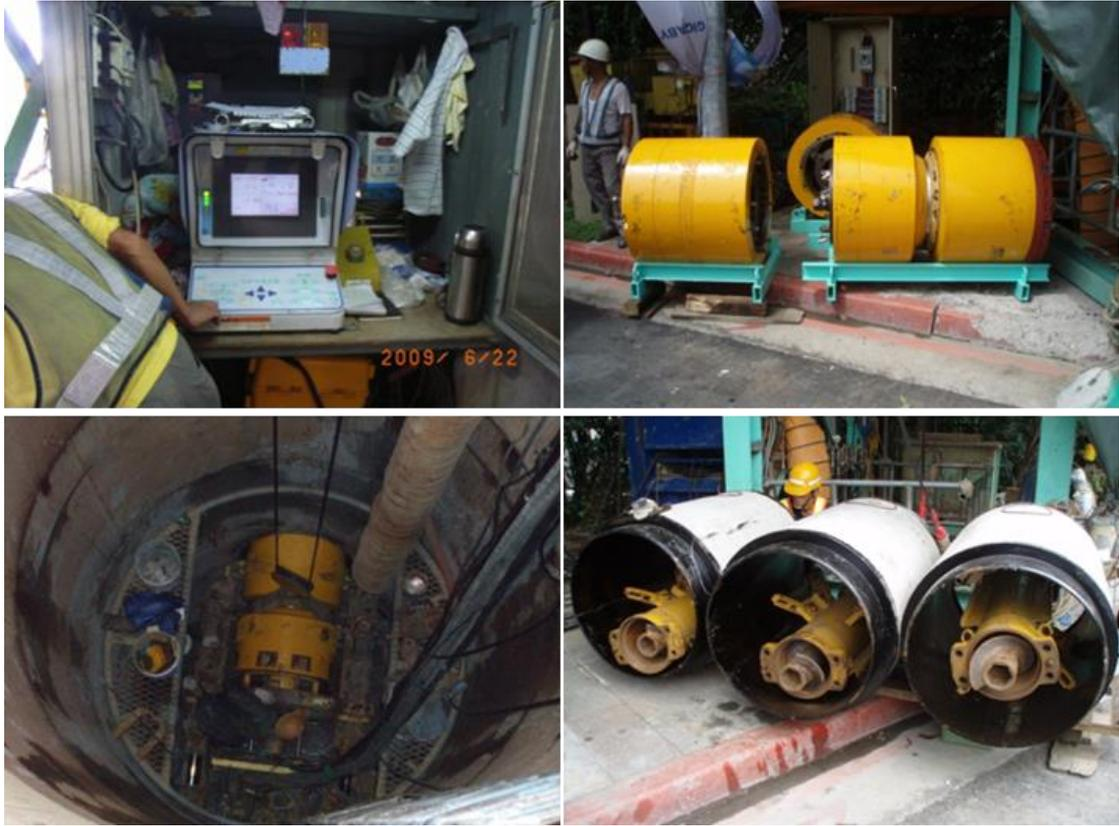
圖4-81 安裝機頭並推進T型短管
