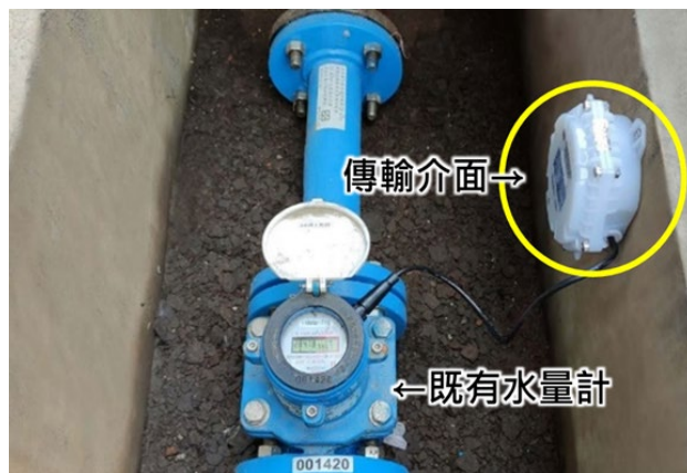
圖 22 75mm 水量計與傳輸介面示意圖
