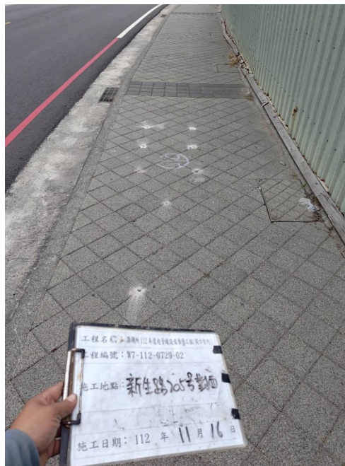
圖 75 現場檢漏畫面(路面無漏水)
