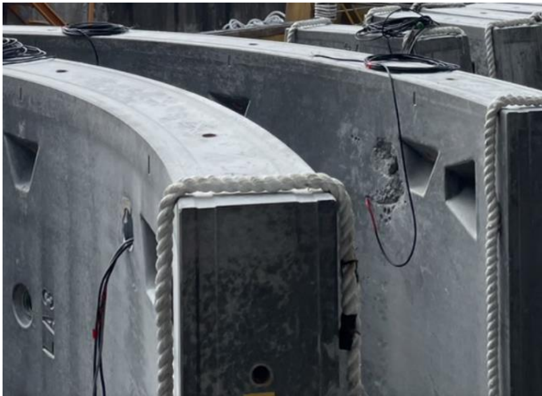
圖 110 接線後照片，左側為正常的出線方式，右側為鑽洞之方式
