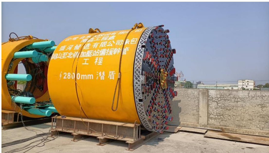
圖 48 岡山至北嶺加壓站備援幹管工程潛盾機
