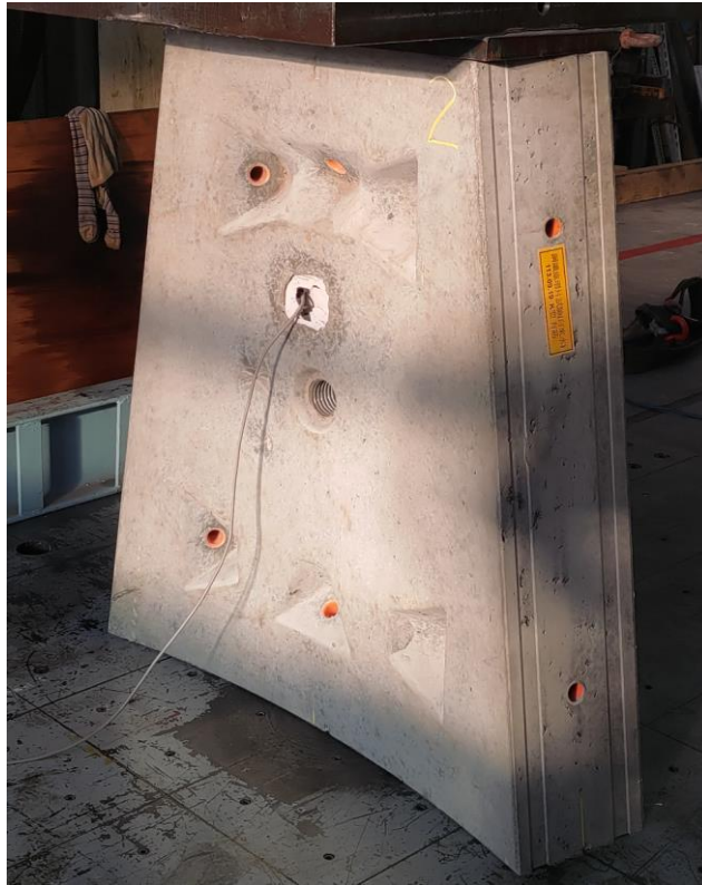
圖 129 鋼筋維混凝土 K 環片測試過程皆無變化
