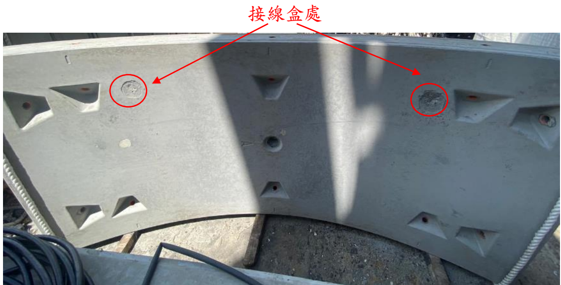
圖 108 A 型普通環片(有筋)內側面
