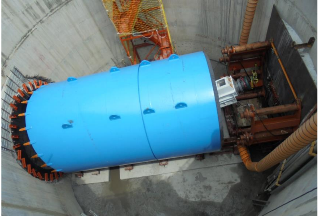
圖 50 三義交流道至三義減壓池 1000m/m 管線接續工程破鏡照片
