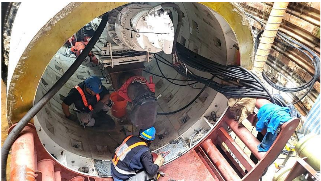
圖 51 大湳系統送龜山林口複線工程施工照片
