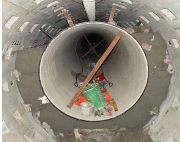
圖 6 管外灌漿施工範例
