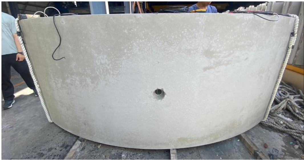
圖 101 A 型普通環片(有筋)外側面
