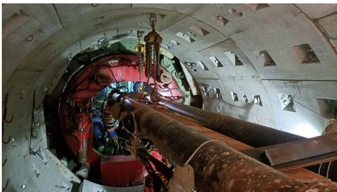
圖 49 岡山至北嶺加壓站備援幹管工程施工照片
