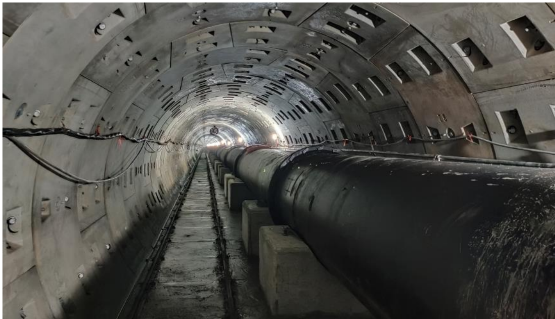
圖 7 三義潛盾隧道設維修廊道範例
