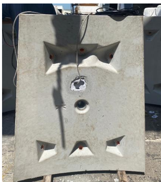
圖 104 K 型普通環片(有筋)內側
