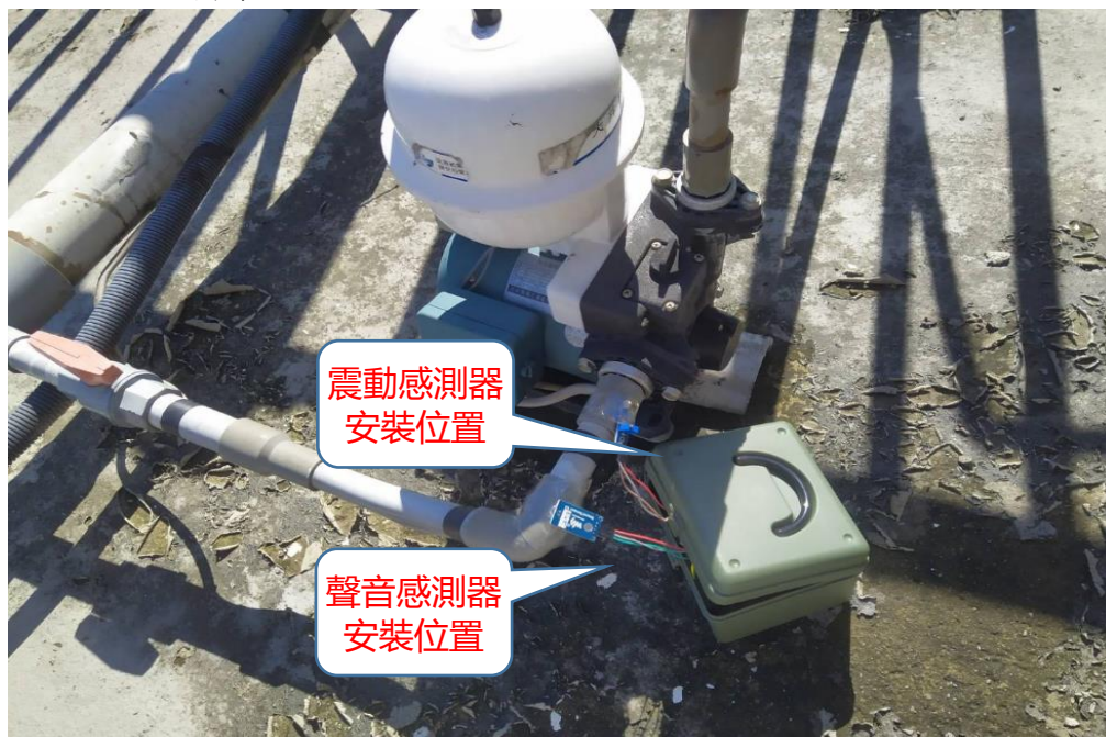
圖 70 震動與聲音感測器裝設位置圖
