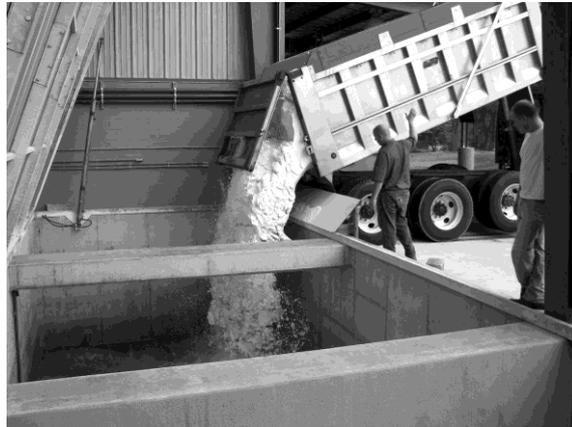
圖5.1-3 通過自卸車接收鹽的儲鹽坑示例<sup>[1]</sup>
