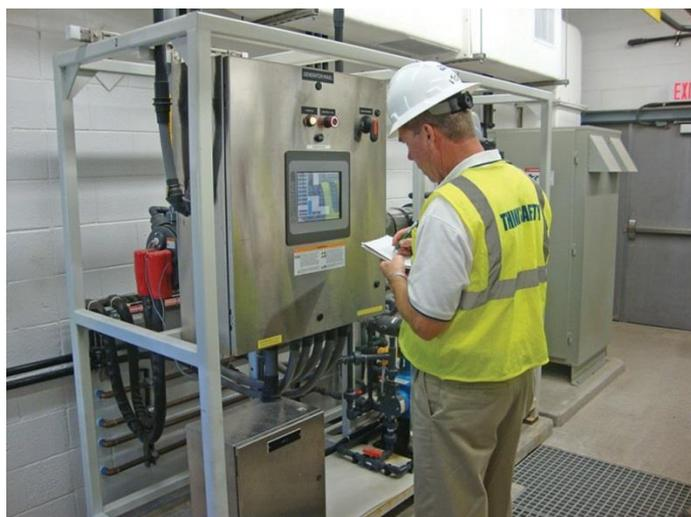
圖6.2-5 OSEC® B-PAK 次氯酸鈉生成系統在淨水場內操作巡檢情形
