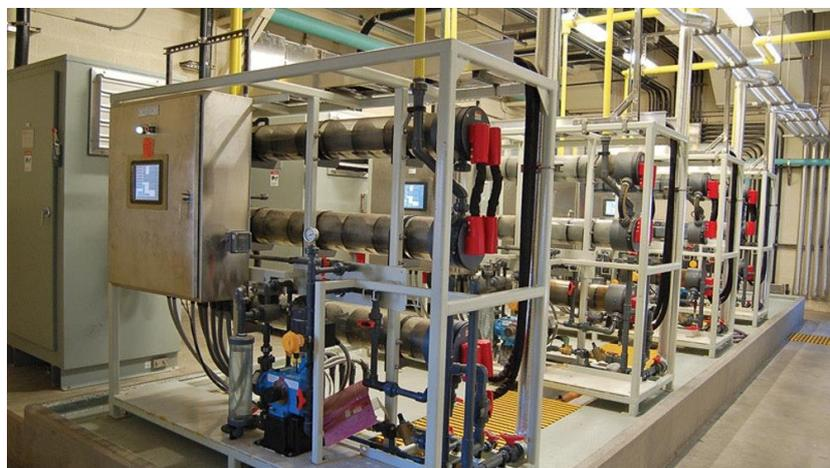
圖6.2-4 OSEC® B-PAK 次氯酸鈉生成系統在淨水場內裝設情形
