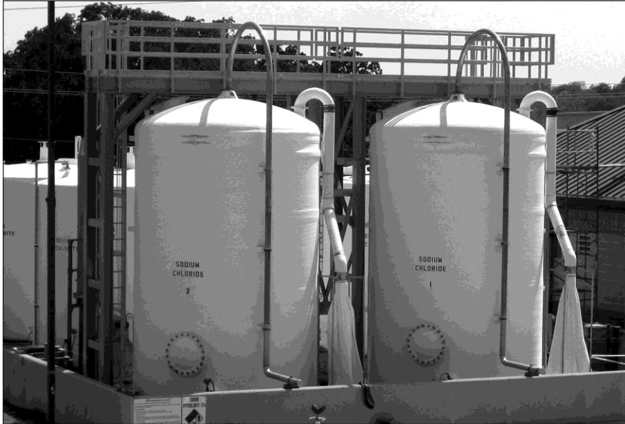
圖5.1-2 用於儲存鹽和鹽水溶液的大型“鹽水”FRP系統示例<sup>[1]</sup>
