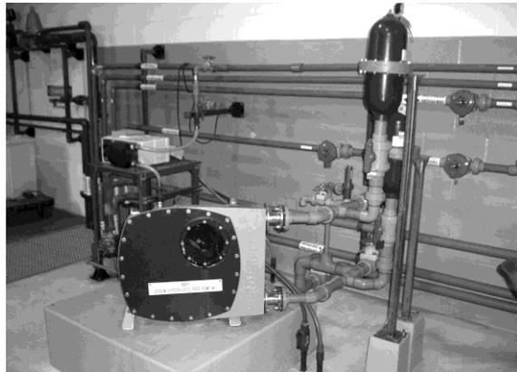
圖5.1-7 OSG 系統的典型軟管泵方向<sup>[1]</sup>
