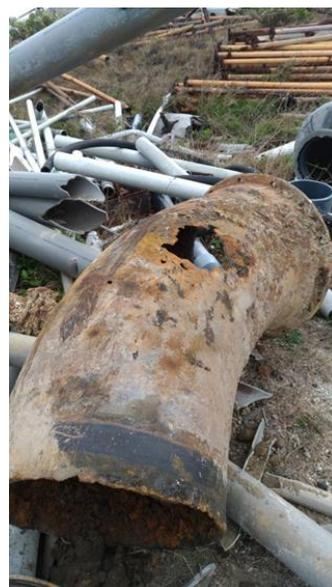
澎湖地區供水管線腐蝕狀況圖
