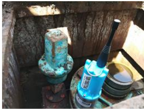
圖 3-25 噪音收集器安裝於閥栓上
