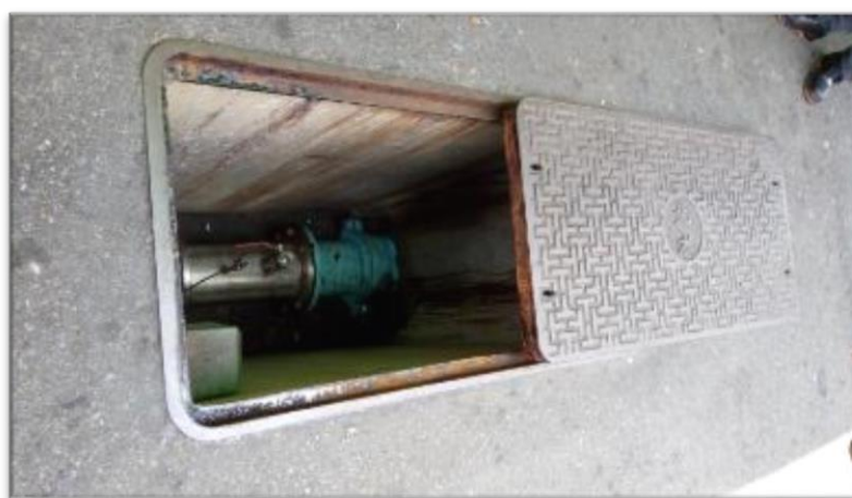
圖 2-8 流量計及記錄器安裝於窰井
