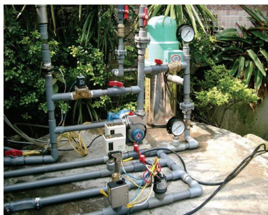
圖3 廠商新研發間接加壓機組（自來水廠商開發）
