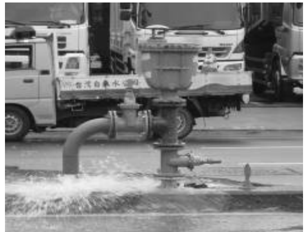
圖 11 人力進行管線排氣(水)作業
