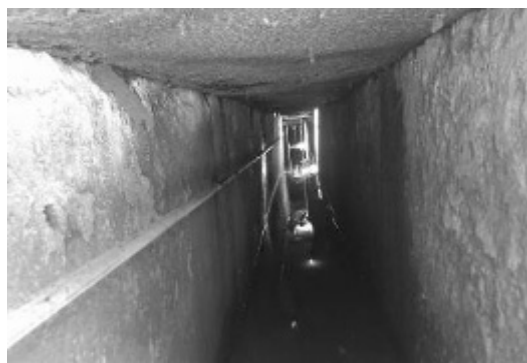
圖 12 完成後水溝內情形
