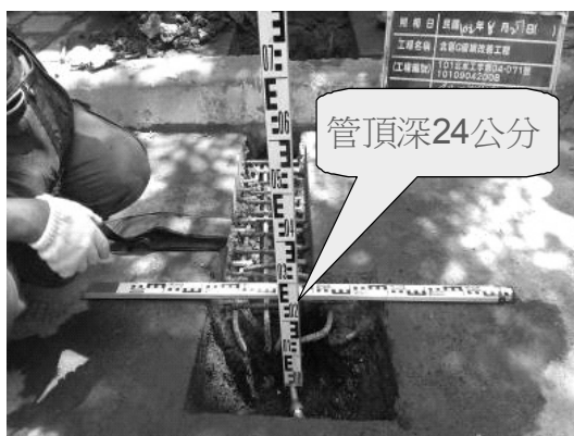
圖 10 水溝邊給水管深度情形
