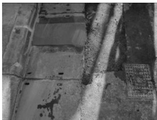
圖 13 預鑄溝蓋版復原情形
