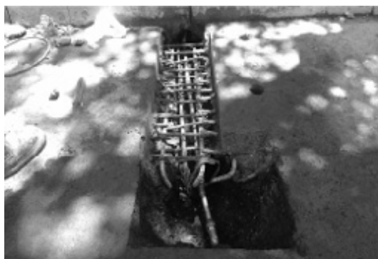
圖 9 將水管置於溝蓋版內情形
