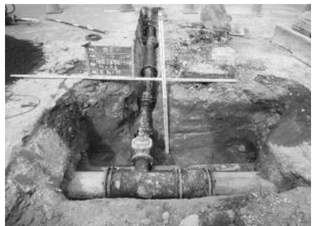
圖 12 第三階段限水段斷管連絡改接工程
