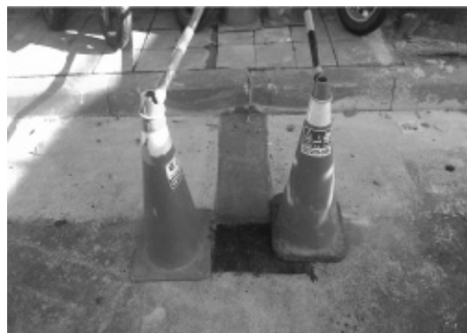
圖 11 場鑄溝蓋版復原情形
