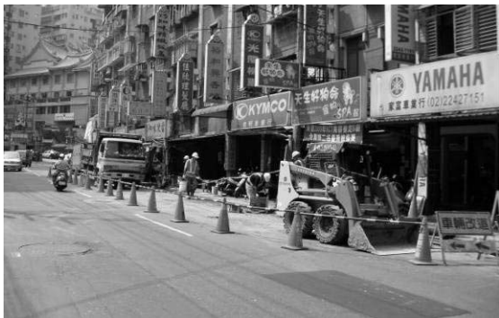
圖 6 管網改善施工
