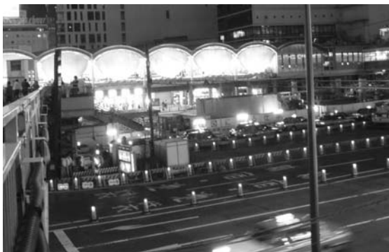
圖 8 國外施工擺放交通錐情形
