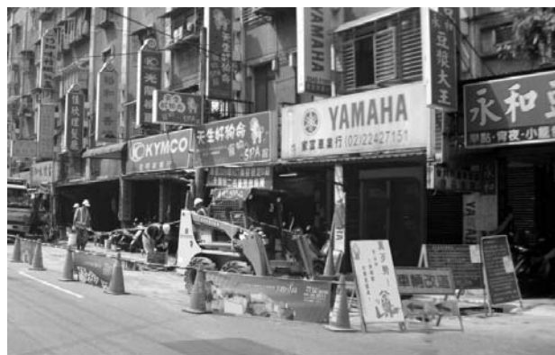
圖 19 管網改善工程現場
