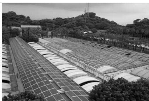
圖 2 公館淨水場屋頂建築與太陽能設備,展現綠色供水城市之美
