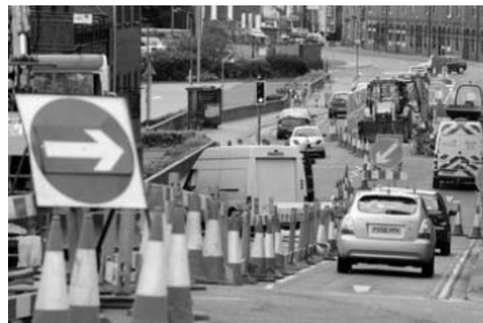
圖 9 國外施工擺放交通錐情形 [6]
