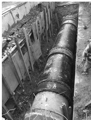
圖 4 組裝完成照片
